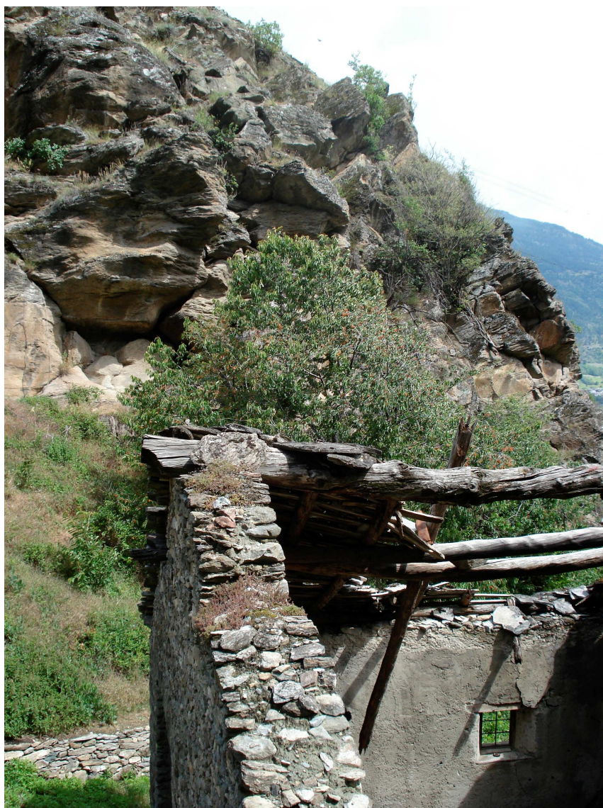
Foto 7.1 Ammasso roccioso parete loc.Peranche
