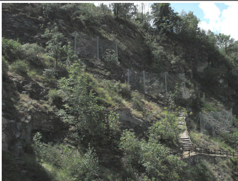
Foto 8.4 Opere di protezioni passive a difesa del capoluogo di Villeneuve
